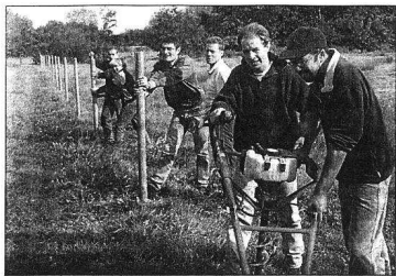
Aux confins des communes d'Amanlis et de Piré-sur-Seiche, une équipe de six adhérents de l'Écureuil achève la pose des poteaux bordant le nouveau sentier pédestre.
